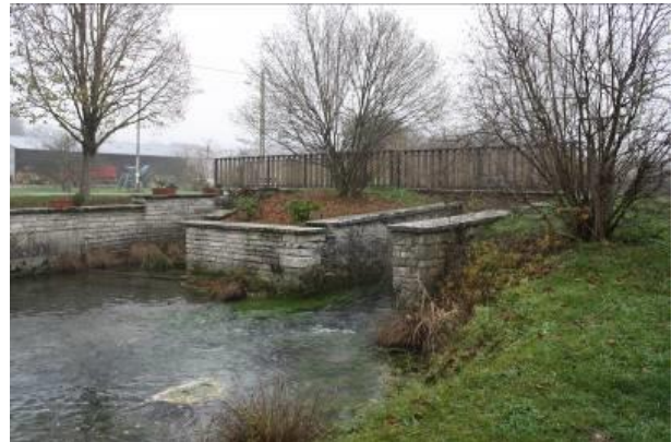
Passerelle pour accéder au lavoir
