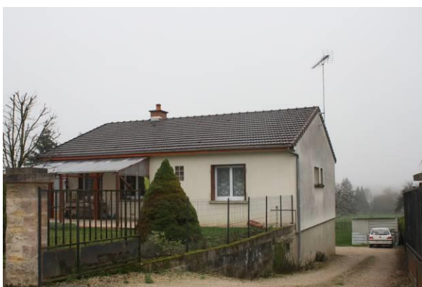
Construction sur sous-sol
