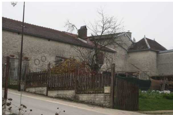
Espace de jardin aménagé dans la pente
