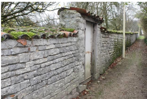
Petit porche et mur de pierre (la Ruellotte)
