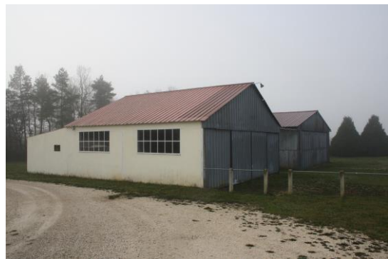
Les bâtiments techniques de l'aérodrome
