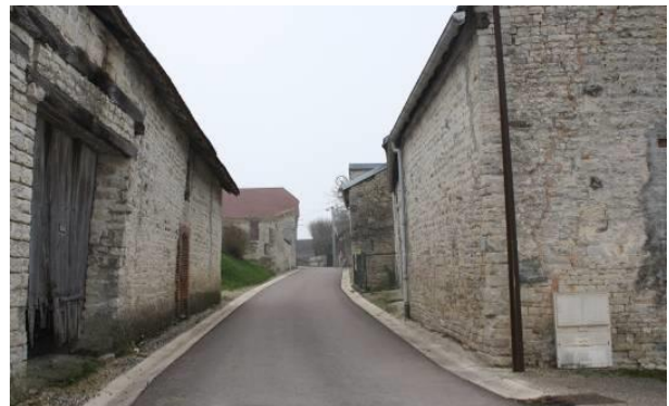
Implantation à l'alignement – vue sur site
