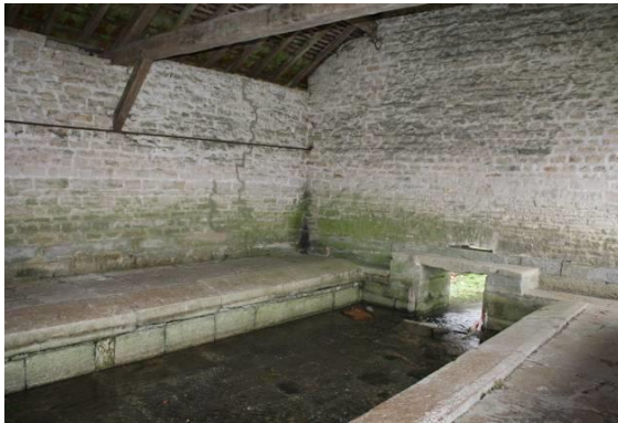
Intérieur du lavoir (entrée Nord-Ouest)
