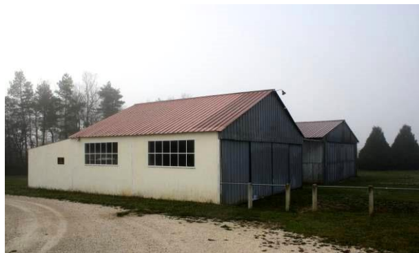
Les bâtiments techniques de l'aérodrome
