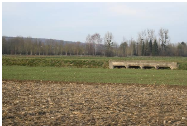
Les aménagements pour permettre l'écoulement des eaux dans la vallée
