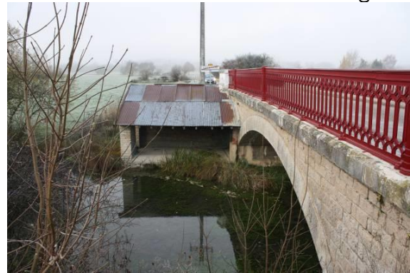
Lavoir au pied du pont à l'entrée Sud-Ouest
