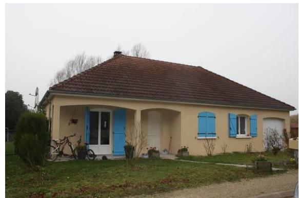
Construction récente – teinte contemporaine en décalage avec celle du tissu ancien
