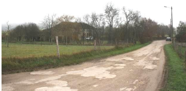
Rue des Longennes, frange végétale existante à l'Est
