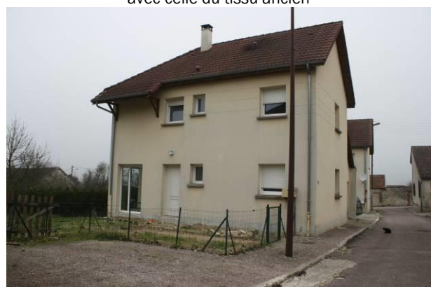
Construction récente à l'alignement
